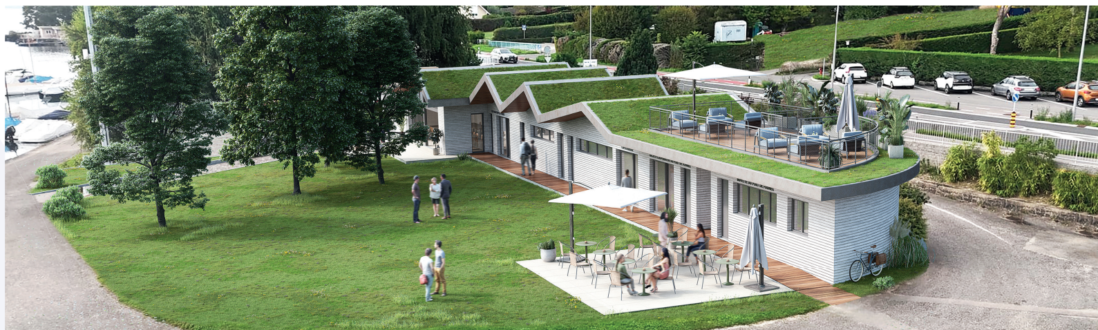
Le bâtiment niché en lisière de la prairie
