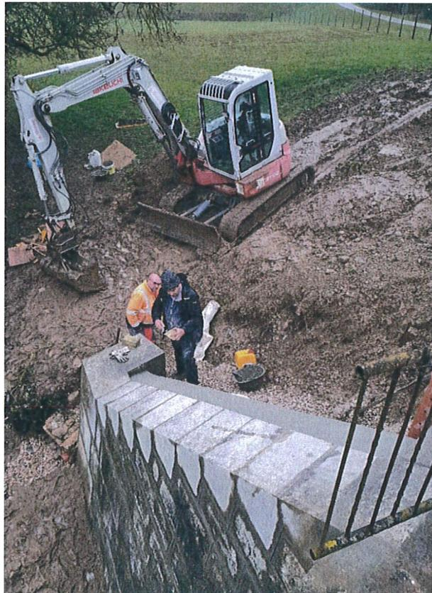
*Réfection du mur en aile lors du sondage*
