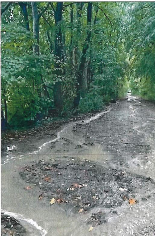
L'évacuation des eaux sera retravaillée en mettant en place des traverses alpines. Cette intervention permettra à terme de réduire les dégâts sur le chemin tout en simplifiant l'entretien. Cependant, lors des travaux, une intervention devra être faite sur les banquettes herbeuses. Celles-ci seront partiellement décapées et notre passage sera malheureusement visible pendant quelques temps.
