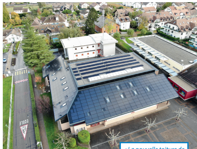
« La nouvelle toiture de la salle de gym »
